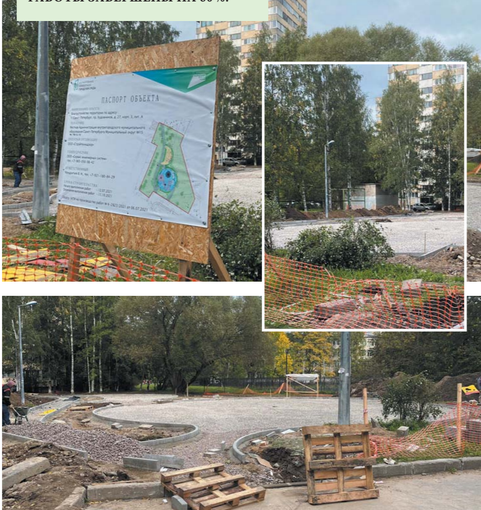
ПР. ХУДОЖНИКОВ, Д. 27, КОРП. 3 РАБОТЫ ЗАВЕРШЕНЫ НА 60 %.
