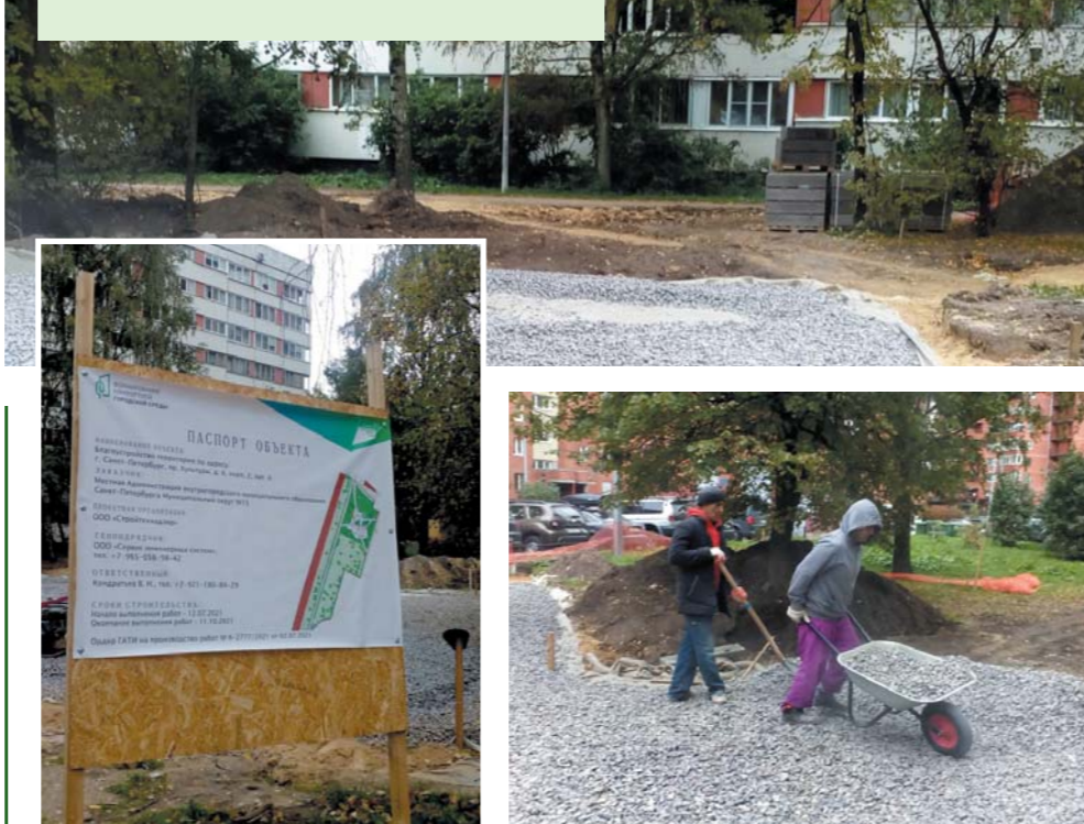
ПР. КУЛЬТУРЫ, Д. 6, КОРП. 1 РАБОТЫ ЗАВЕРШЕНЫ НА 40 %.
