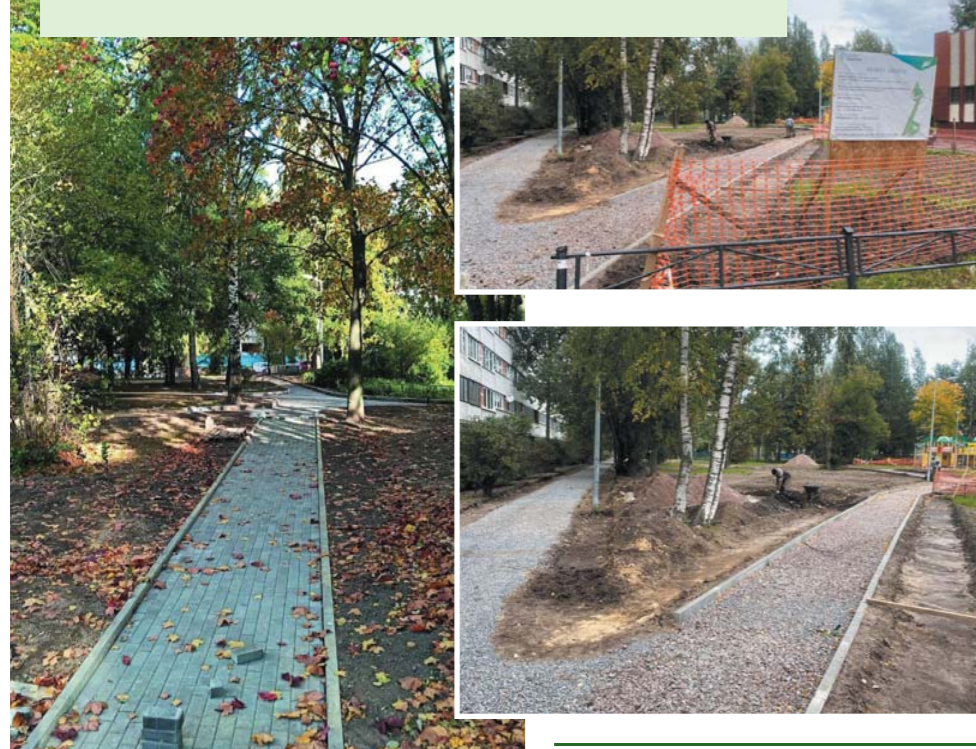
УЛ. РУДНЕВА, Д. 5 КОРП. 1; УЛ. РУДНЕВА, Д. 7, КОРП. 1 РАБОТЫ ЗАВЕРШЕНЫ НА 66 %.
