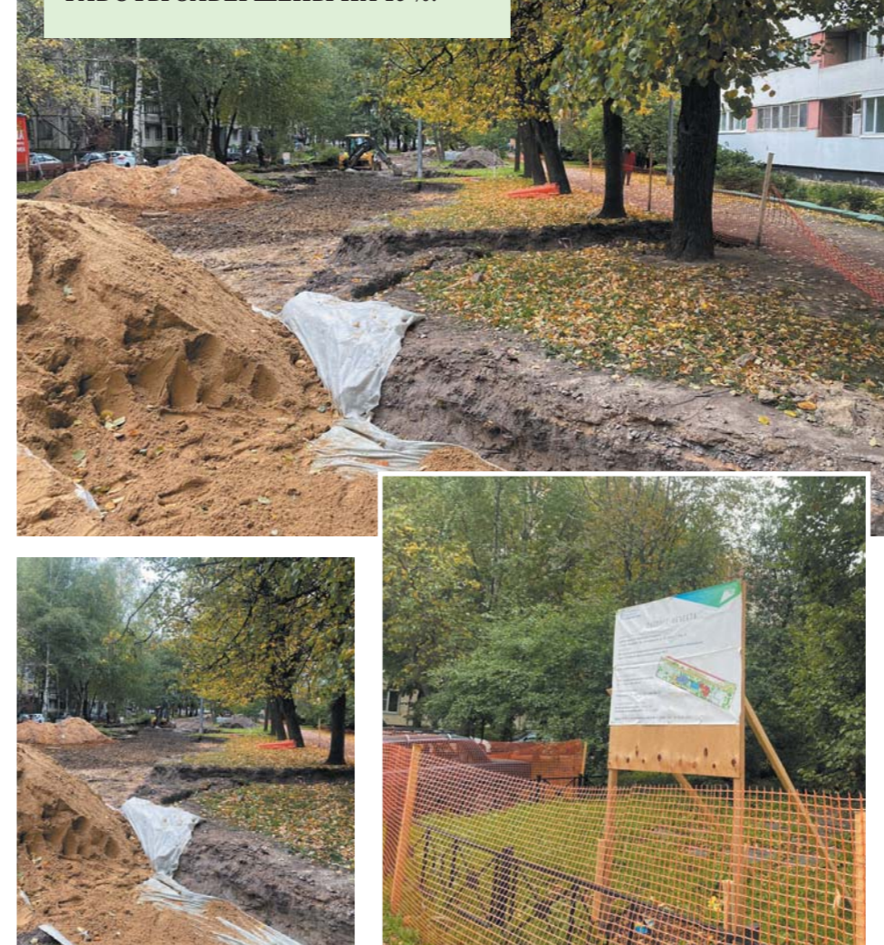
ПР. ЛУНАЧАРСКОГО, Д. 70, КОРП. 1 РАБОТЫ ЗАВЕРШЕНЫ НА 15 %.
