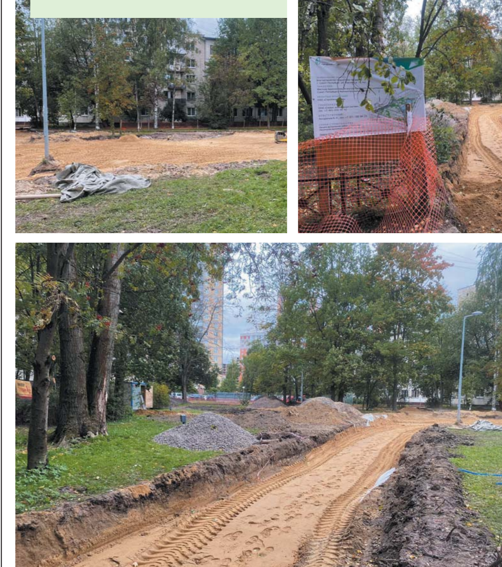
УЛ. РУДНЕВА, Д. 11 РАБОТЫ ЗАВЕРШЕНЫ НА 40 %.
